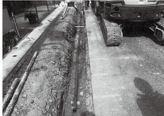
ときわ台の水道工事
