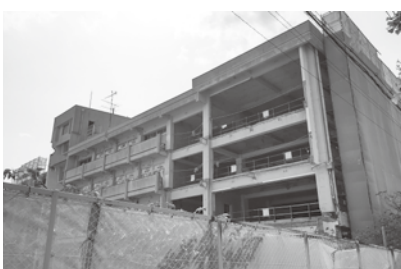
西地区学校施設改修工事
