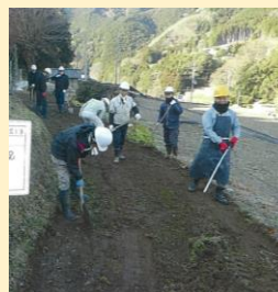
▲農道を直営施工(川尻)
