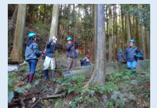
▲地域協働で防護柵設置(牧)
