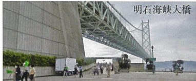
明石海峡大橋
