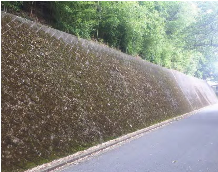
多くの石積擁壁等は存在(例)
