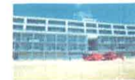
複合施設全体の合同消防訓練
