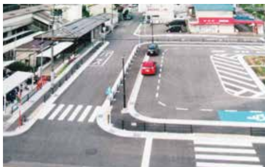
完成したロータリー
