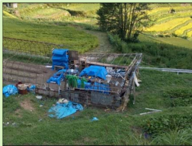
シートが飛び、フレームが曲がる被害をうける
