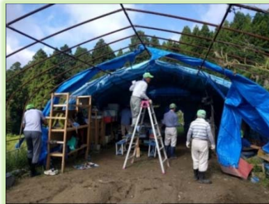
力を合わせて修繕作業
