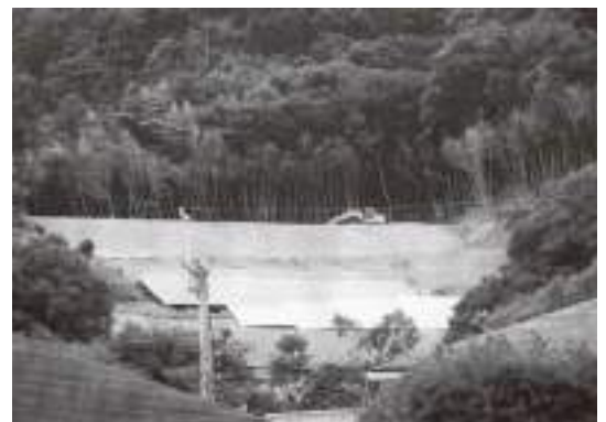
新光風台4丁目太陽光発電の現場
