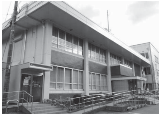
本庁舎は防災の要として機能するのか
