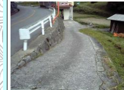
町道向町2号線整備(基幹事業)
