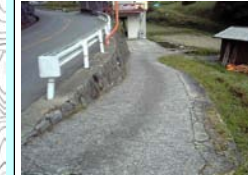
町道向町2号線整備(基幹事業)
